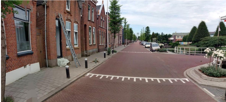
Impressie van het nieuwe asfalt
