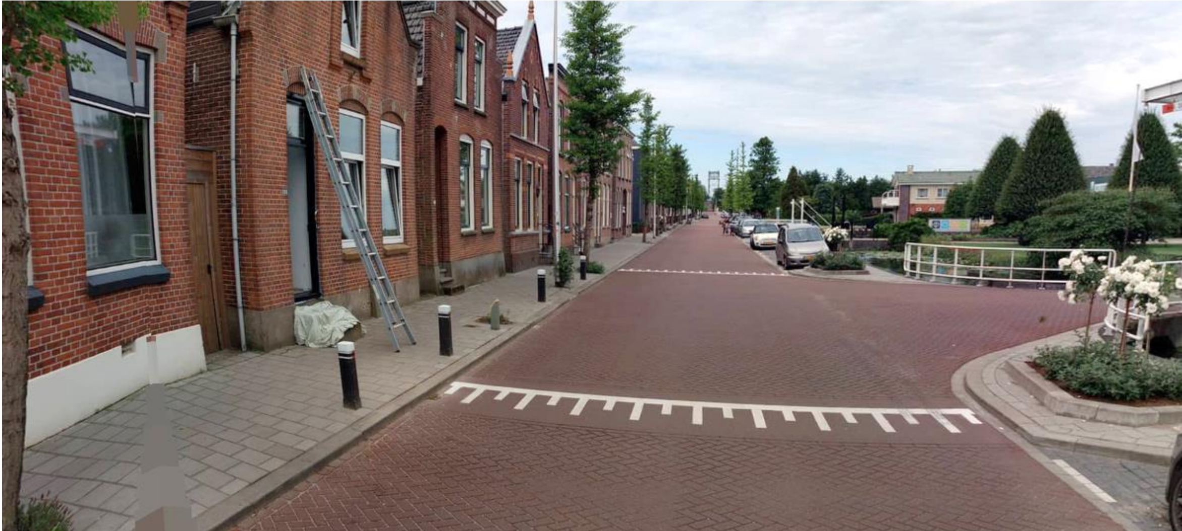
Impressie van het nieuwe asfalt
